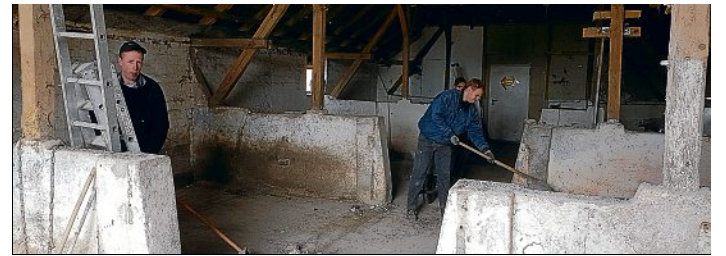
Abriss des Schweinestalls: Größtenteils wurden die Arbeiten in Eigenleistung erbracht.
